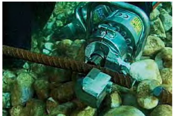
Esecuzione di un taglio sott'acqua Underwater rod cutting
